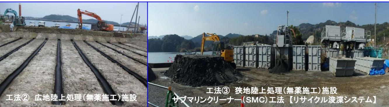
【リサイクル浚渫システム】陸上処理で砂とシルトを除去した海水をサブマリンクリーナーの噴射水に再利用する。
